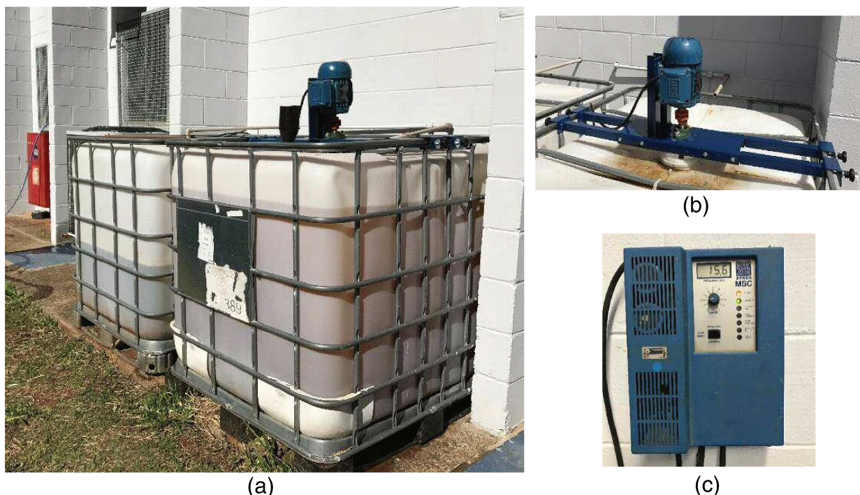
Figura 29. Imagens dos (a) Tanques IBCs adaptados; (b) Conjunto composto por suporte (desmontável) com motor elétrico (2,0 cv), mancal, haste (700 mm) aço inox 316L e misturador tipo paleta reta prolongada com rotação linear controlada por (c) inversor de frequência.
