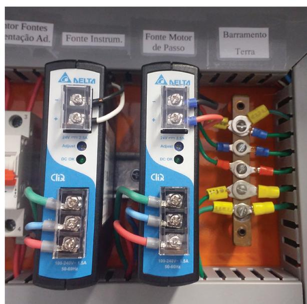
Figura 25 – Fontes de alimentação de corrente contínua e barramento terra.
