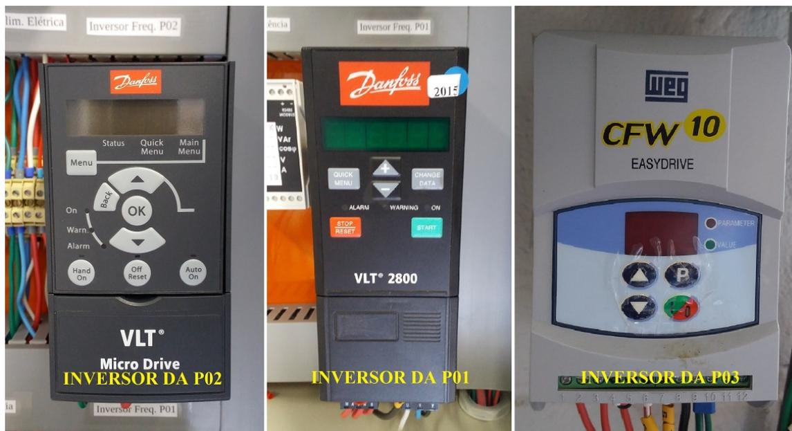
Figura 30 – Inversores de frequência da planta de FAD.
