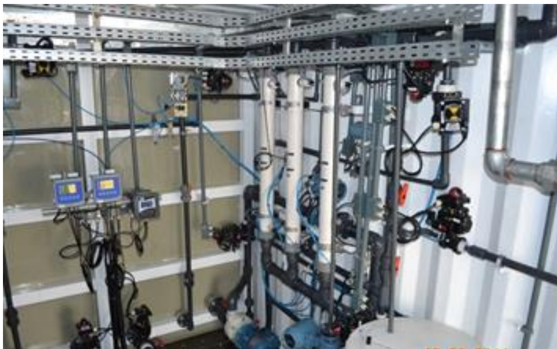
Figura 15. Sistema com processo Air Lift (Fonte: acervo do autor).
