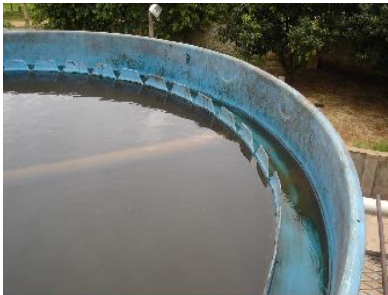
Figura 6. Decantador secundário (Fonte: acervo do autor).
